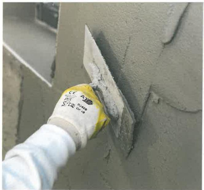
Auftrag der rissüberbrückenden, mineralischen Dichtungsschlämme, hier die Kombiflexabdichtung.
