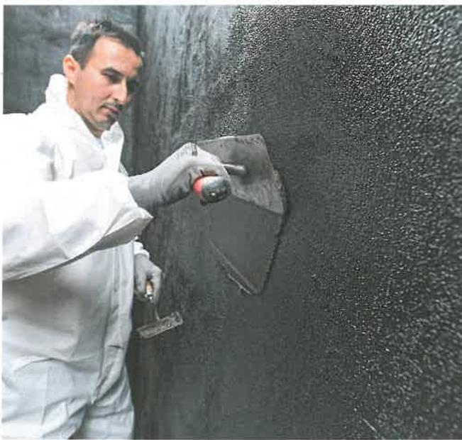
Auftrag der kunststoffmodifizierten Bitumendickbeschichtung KMB, hier mit Isotec-VAS.
